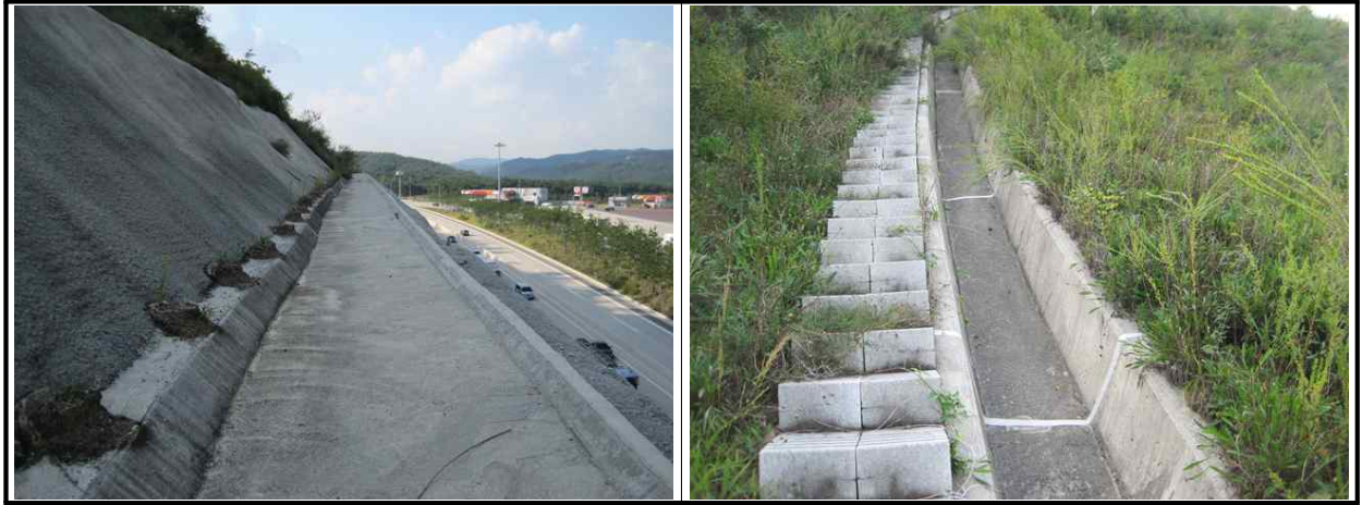
【그림 40.3.3】 배수시설 전경
